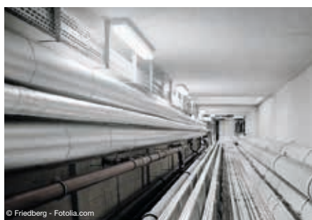
Befestigung von Kabelschächten
